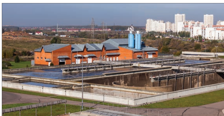
Рис. 5. Очистные сооружения Южного Бутова, производительность – 80 тыс. м 3 /сут
